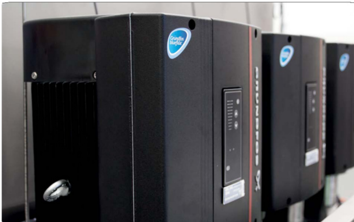
LDC-Q 720/20 с тремя насосами 11 кВт и опциональной буферной емкостью.
