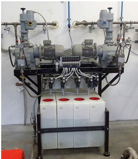
Поток каждого дозирующего насоса подключен к выходу горячей воды высокого давления каждого теплообменника.
